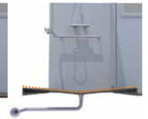
Con una sola inclinación y la conducción plana del agua, los escalones desaparecen
